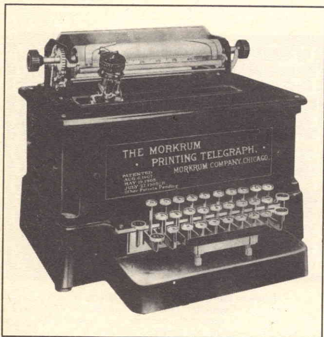
Fig. 6 - L'inserzione in una rivista diceva «la più moderna telescrivente del momento» era vero, ma nell'anno 1908. Si tratta infatti della telescrivente Morkrum, una compagnia fondata nel 1907 per lo sfruttamento dei brevetti di C. L. Krum.
